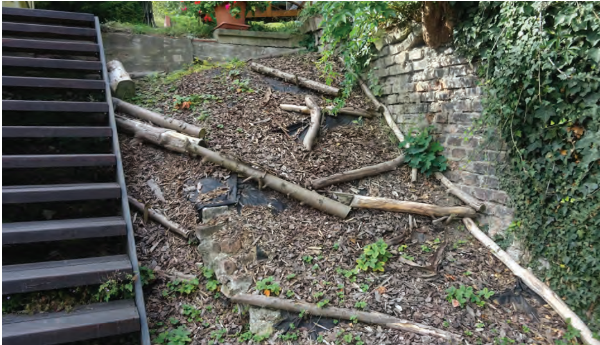
Foto 169: Haus Nazareth, Treppenaufgang an Westseite
