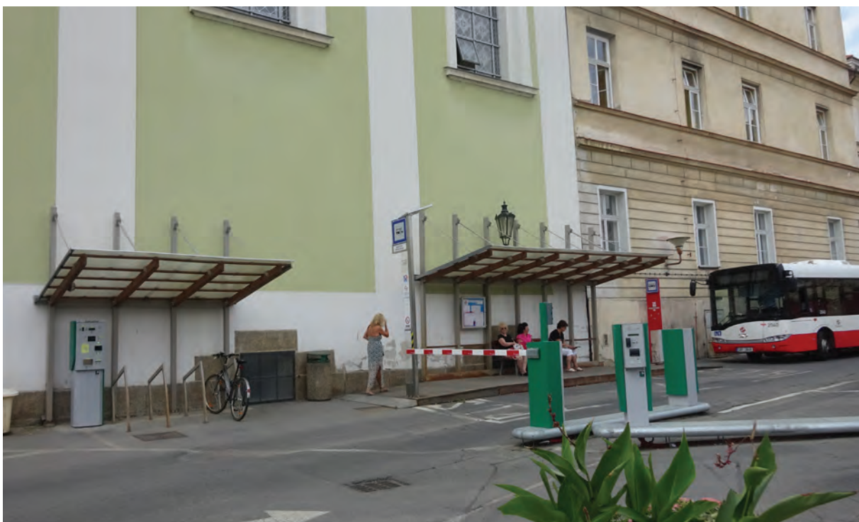
Foto 030: Zugangsbereich mit Parkplatz, Bushaltestelle an Ostfassade der Kirche
