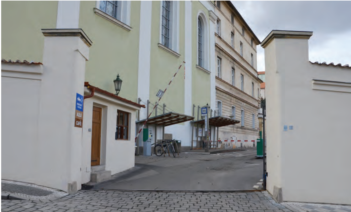
Foto 025: Zugangsbereich mit Parkplatz, Hauptzufahrt von der Vlašská
