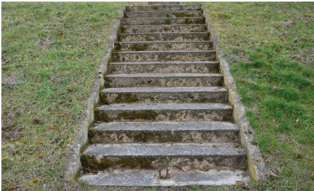
Foto 051: St. Karolusgarten, zentrale Treppenanlage, zweiter Treppenabsatz mit 14 Stufen
