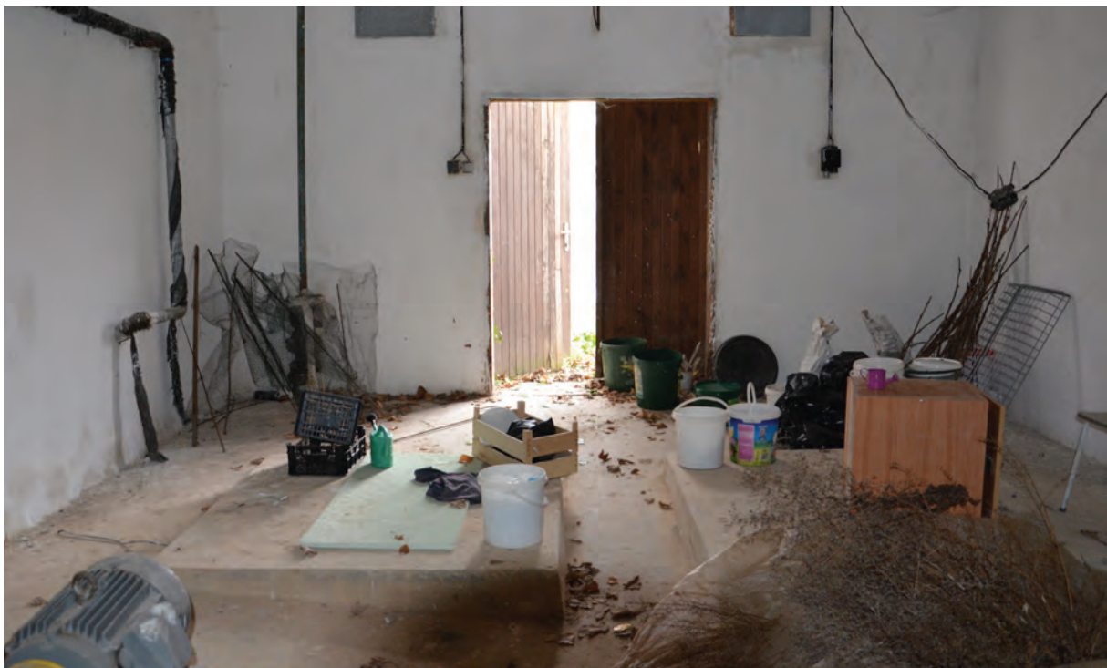
Foto 221: Haus Nazareth, vierte Terrasse, ehemaliges Wasserwerk, Innenraum
