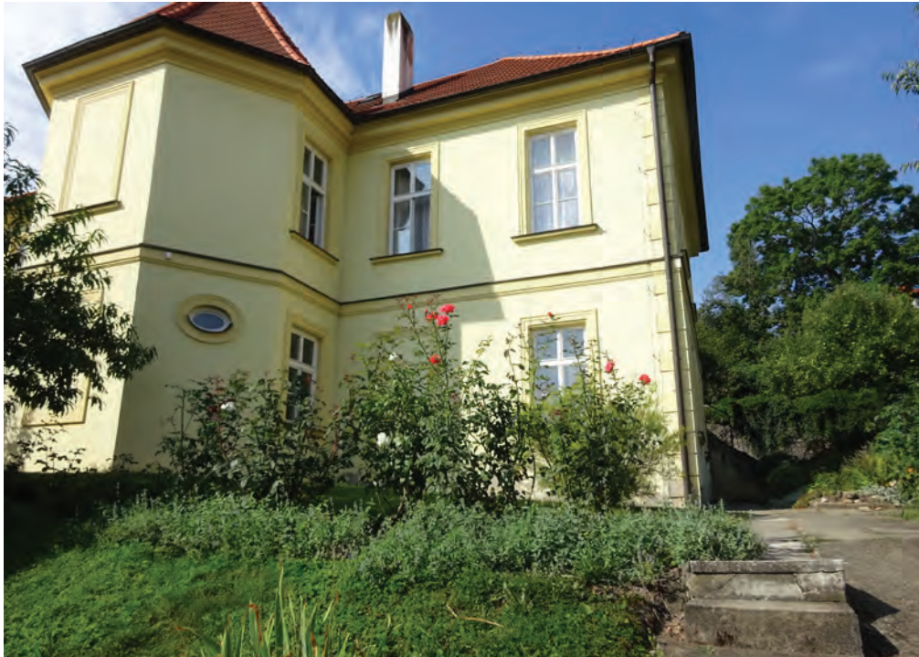
Foto 167: Haus Nazareth, Ostfassade
