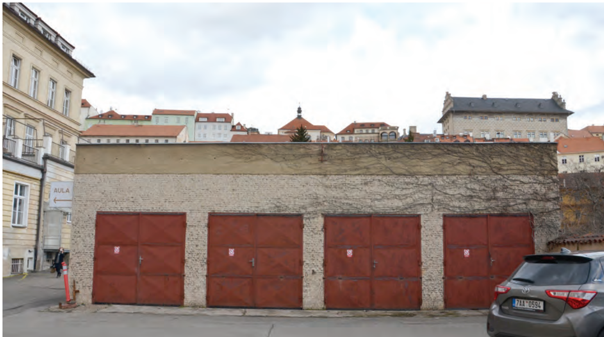
Foto 037: Zugangsbereich mit Parkplatz, Nebengebäude mit Garagen und Trafostation, Ansicht von Süden
