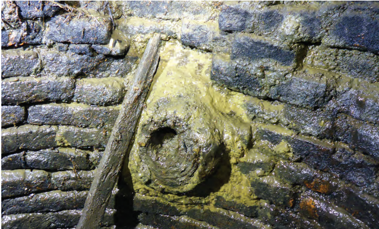
Foto 241: Technischer Bereich, Brunnen (S5), hölzerner Abfluss
