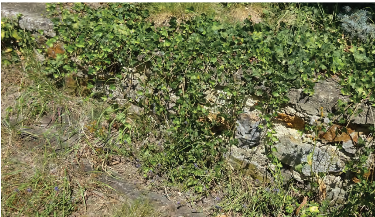
Foto 055: St. Karolusgarten, Bruchsteinmauer mit Abdeckung vor oberstem Treppenblock
