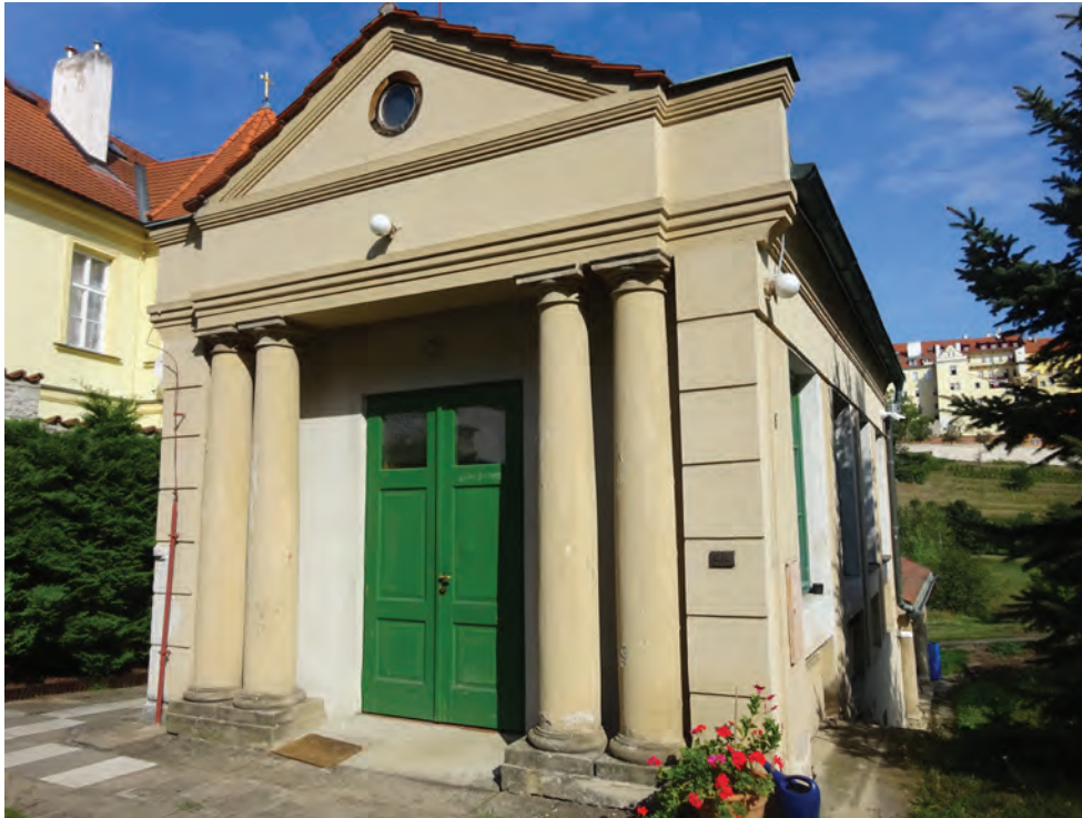
Foto 179: Haus Nazareth, historisches Gartenhaus, Südseite
