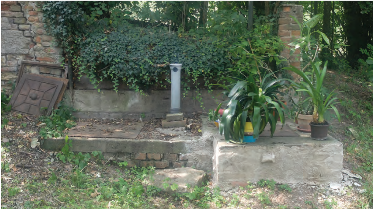
Foto 225: Haus Nazareth, oberste Terrasse, Zugang zum Stollen Nr. XVIII und Revisionschacht (ŠV 1) des Wasserbehälters
