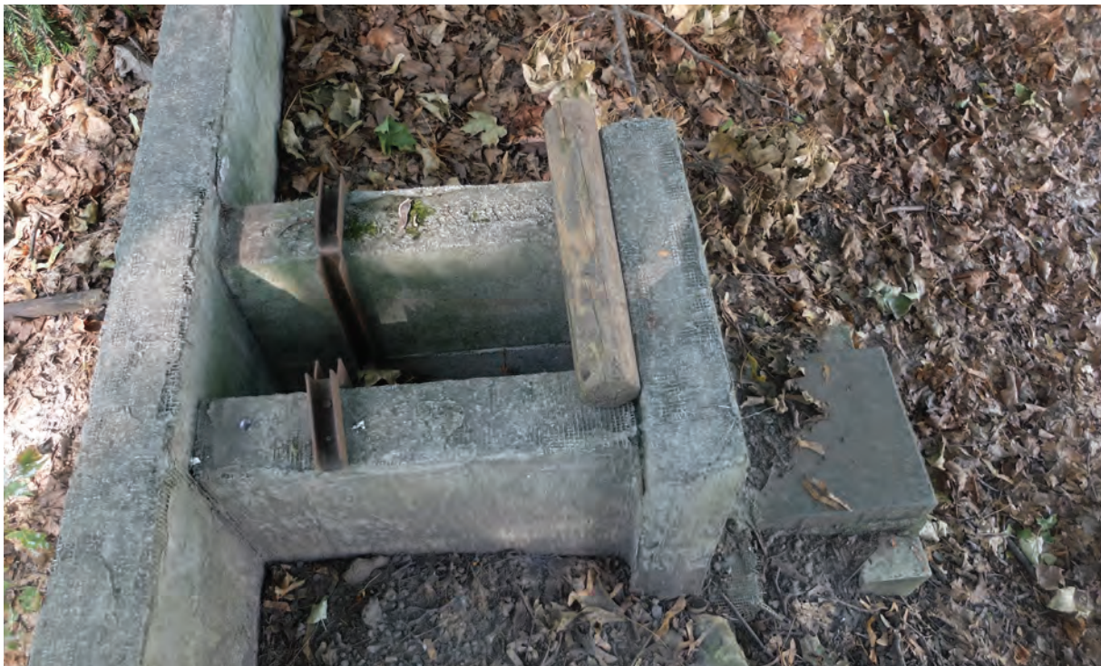
Foto 264: Ehemalige Wasserstelle im Großen Strahover Garten, Betonwehr
