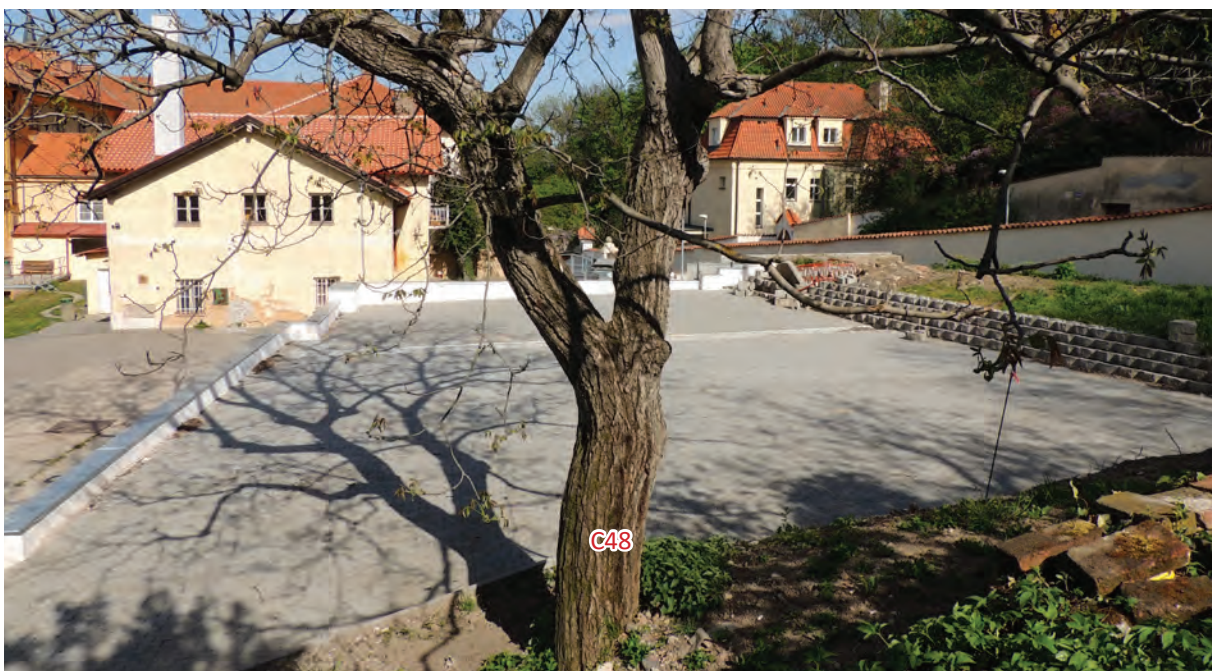
Foto 258: Technischer Bereich, neuer Parkplatz
