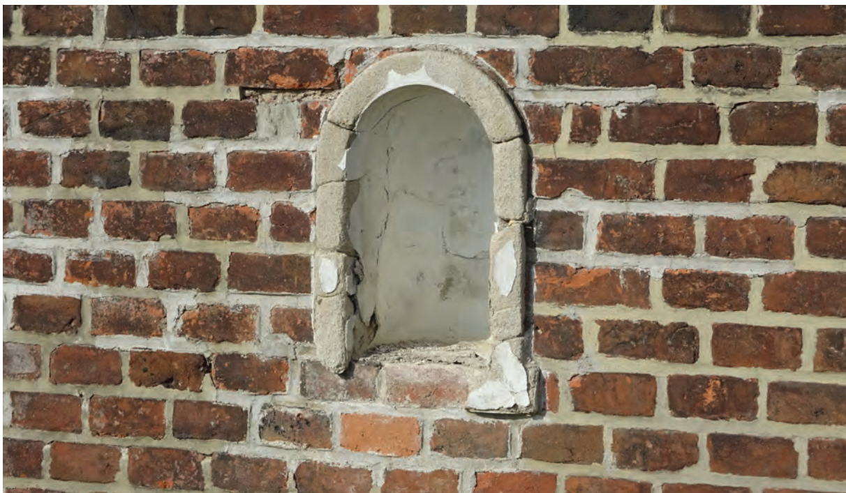
Foto 201: Haus Nazareth, Stützmauer mit Nische
