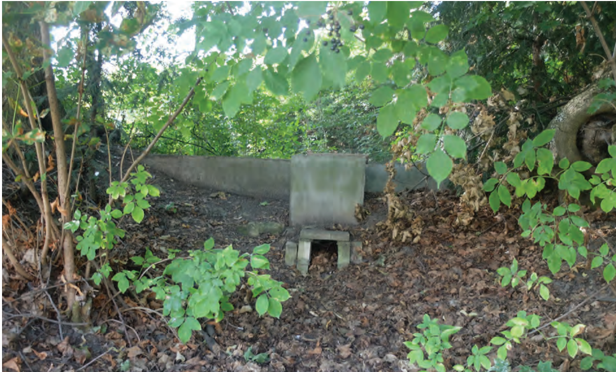
Foto 263: Ehemalige Wasserstelle im Großen Strahover Garten, Betonwehr
