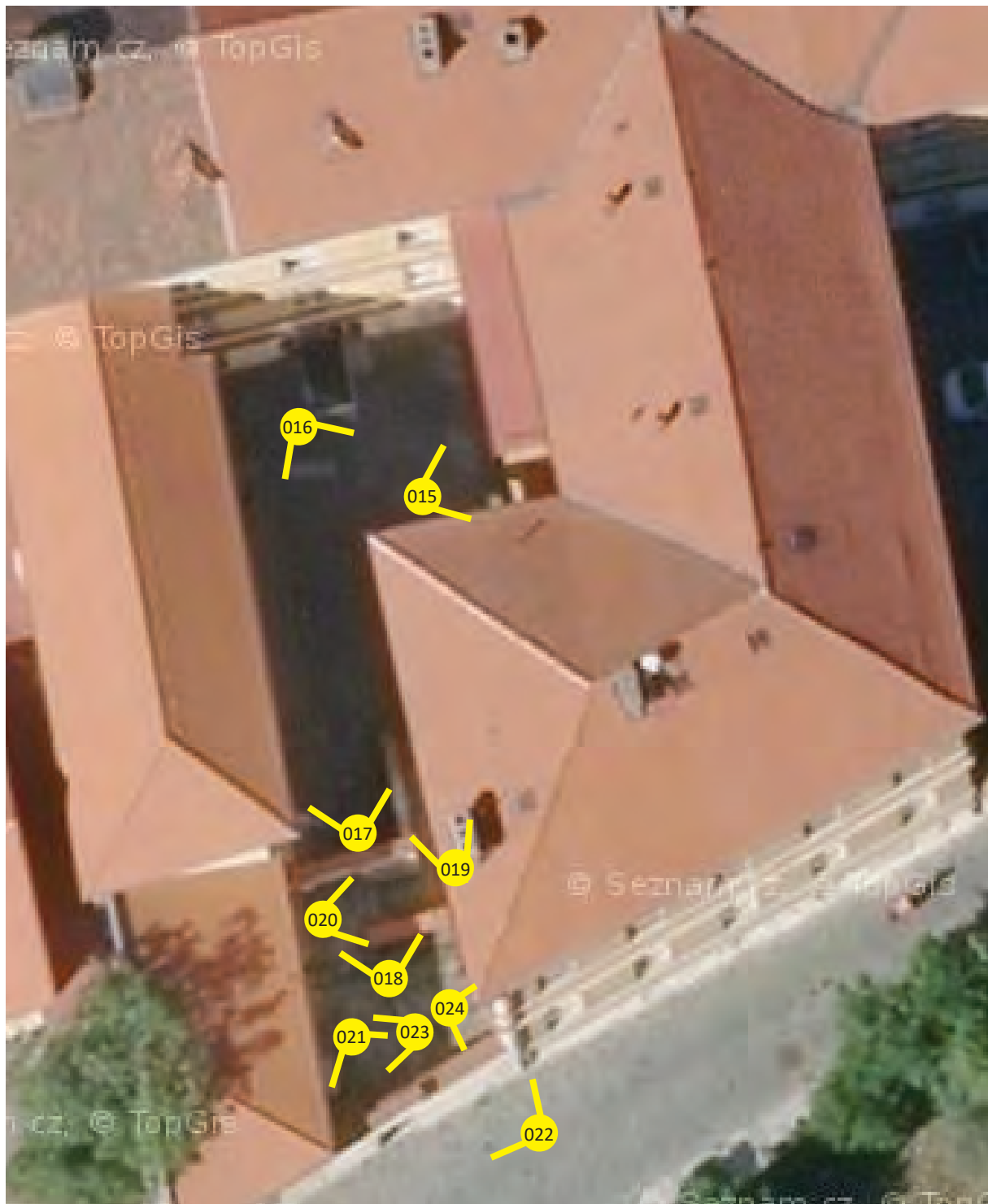
Kleiner Krankenhaushof, Fotostandorte mit Blickrichtung (gelbe Punkte), Luftbild 2018
