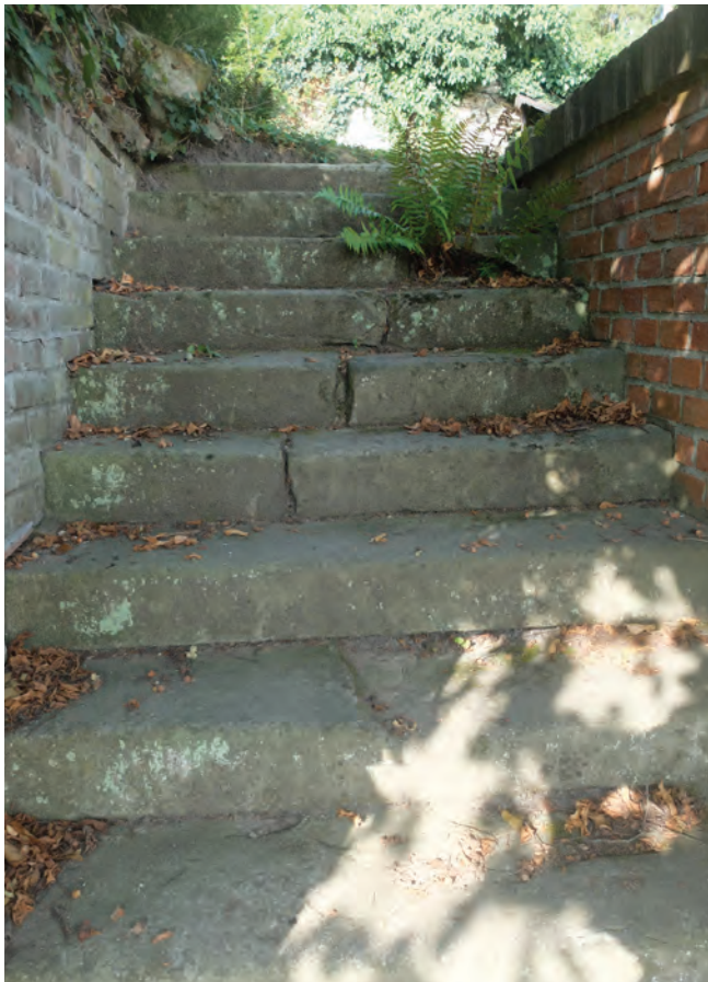
Foto 206: Haus Nazareth, historische Treppe
