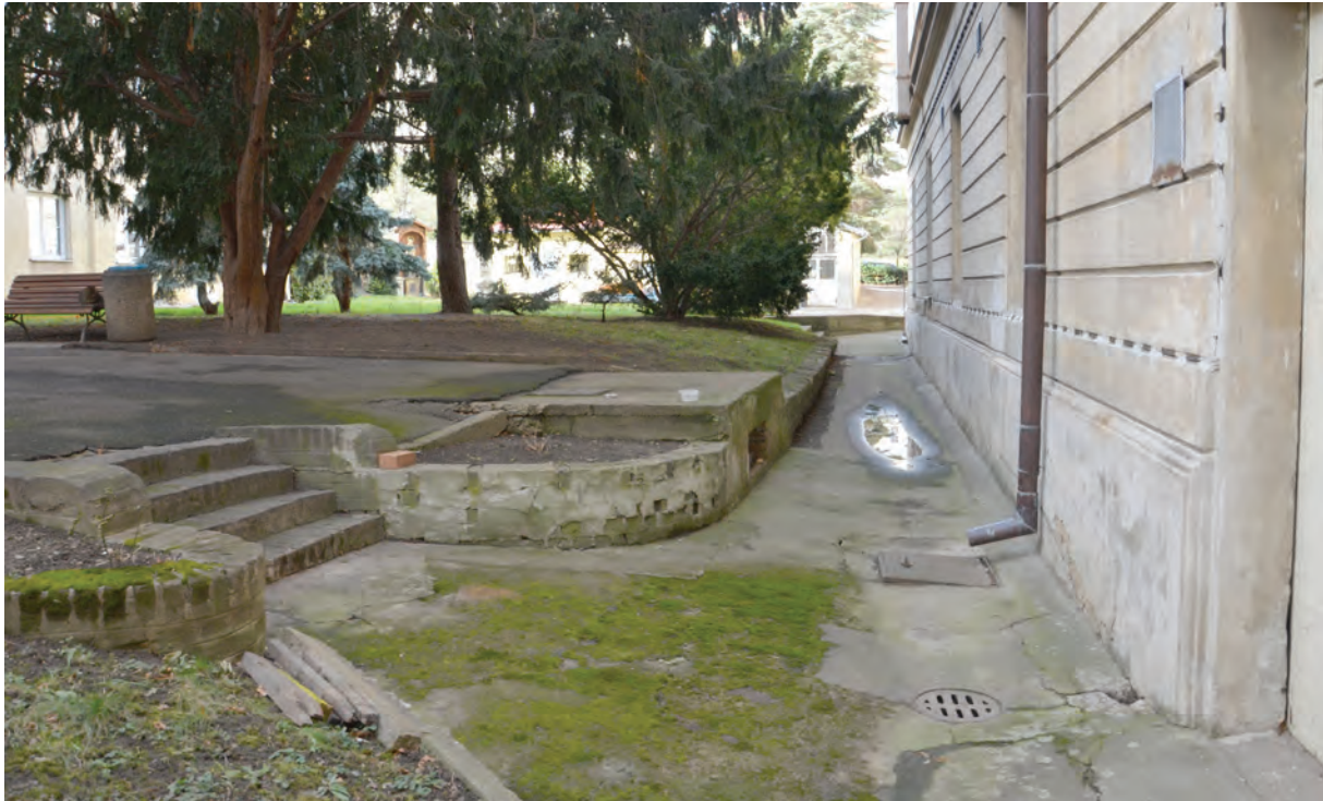
Foto 091: Krankenhaushof, Weg mit Stützmauer und Treppen
