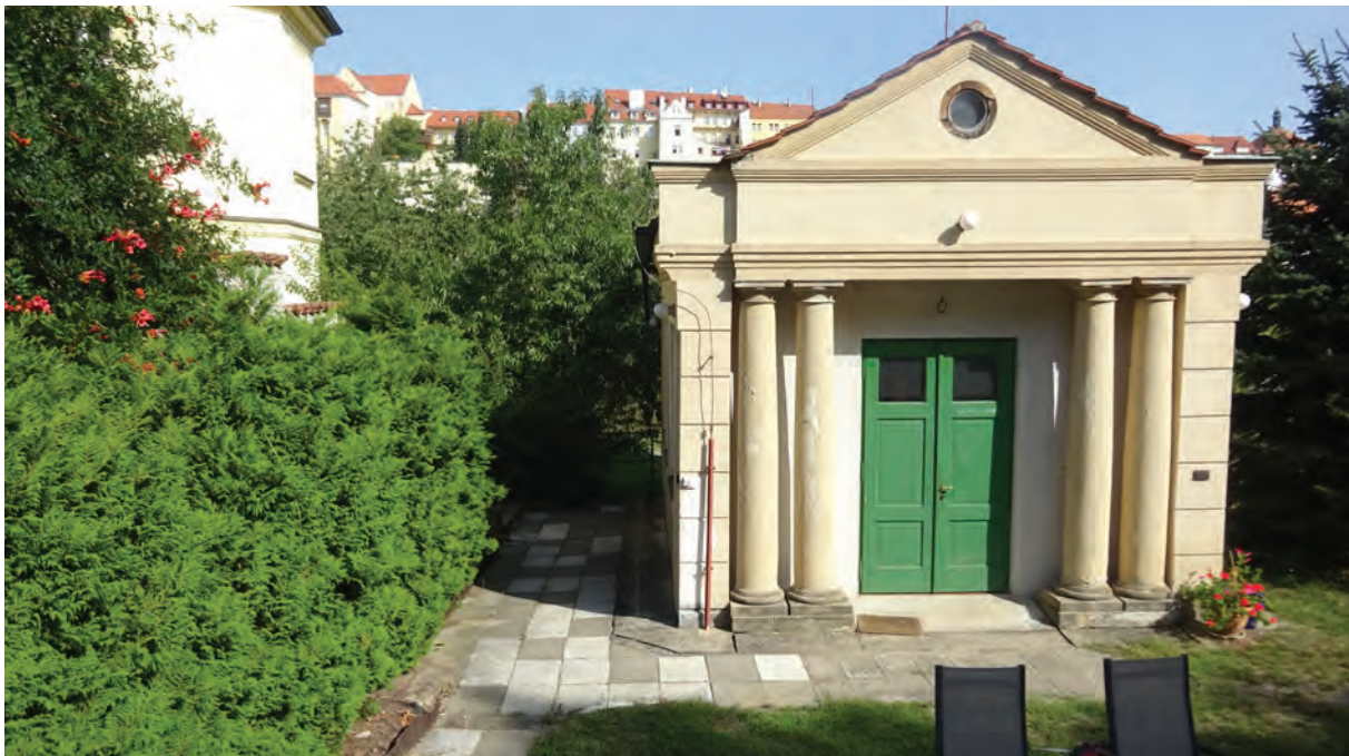
Foto 178: Haus Nazareth, historisches Gartenhaus, Südseite
