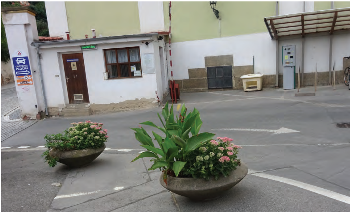
Foto 029: Zugangsbereich mit Parkplatz, Einfahrtsbereich mit Pfortnergebäude
