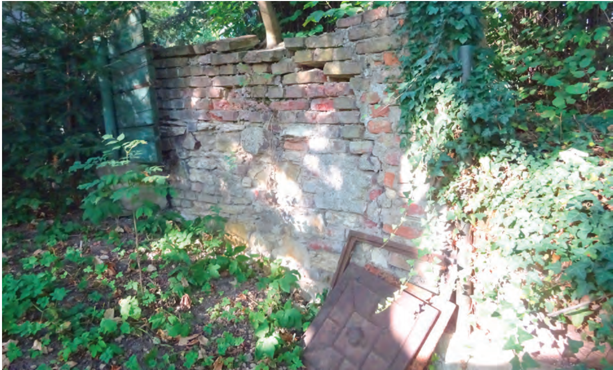
Foto 231: Haus Nazareth, oberste Terrasse
