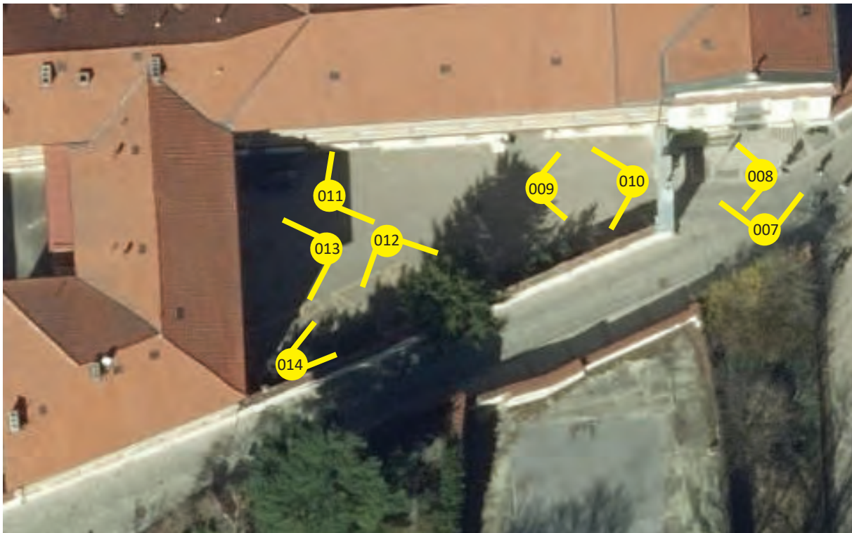
Eingangshof, Fotostandorte mit Blickrichtung mit Blickrichtung (gelbe Punkte), Luftbild 2018
