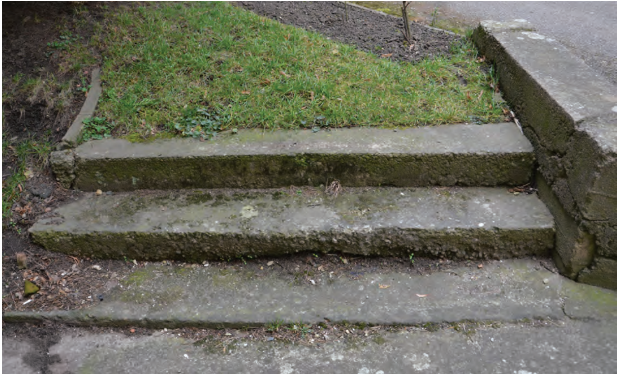
Foto 093: Krankenhaushof, Weg mit Stützmauer, nördliche Treppe
