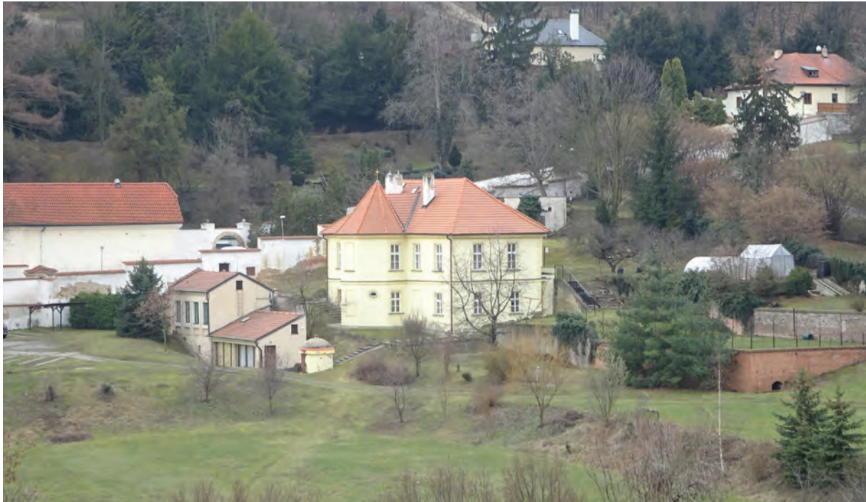
Foto 165: Blick auf das „Haus Nazareth“ und den umliegenden Terrassengarten, Blick von der Úvoz, Blick vom Norden
