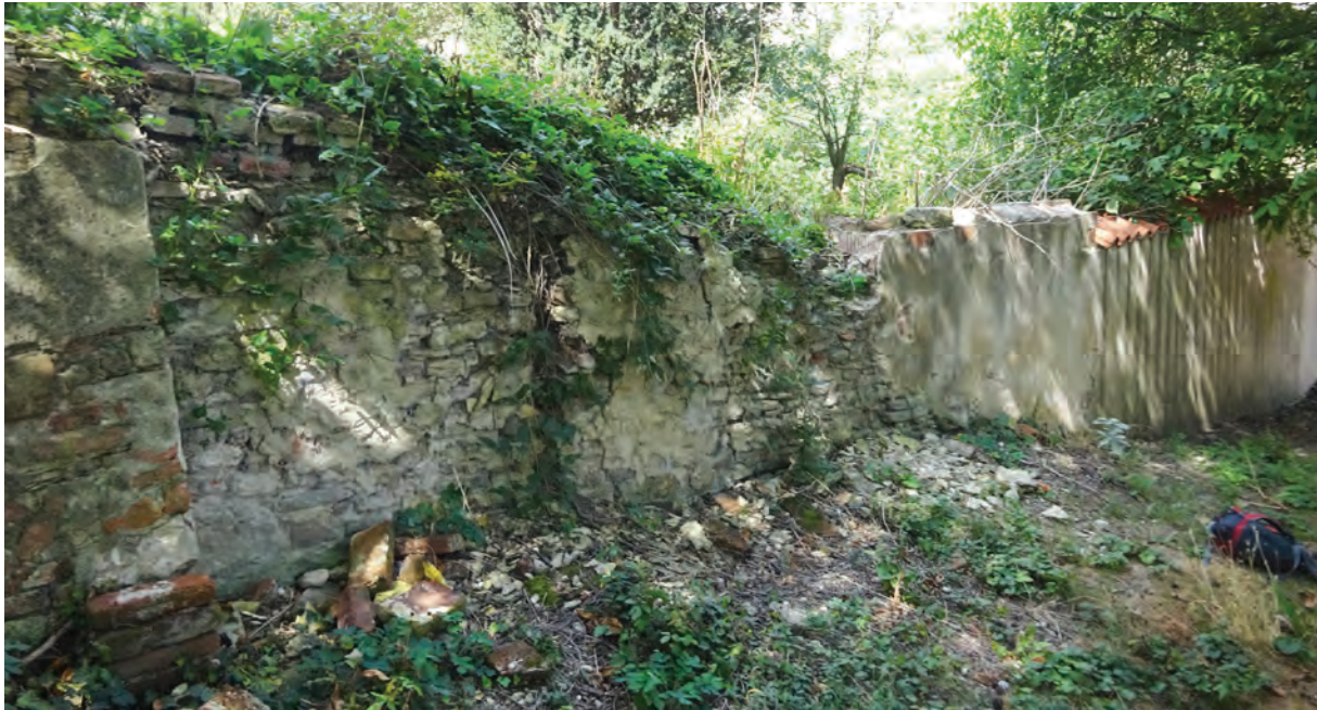
Foto 255: Technischer Bereich, Westseite, historische Mauer
