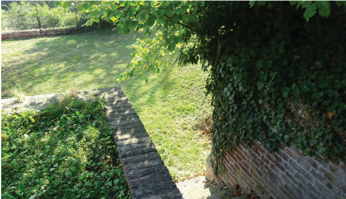
Foto 205: Haus Nazareth, historische Treppe
