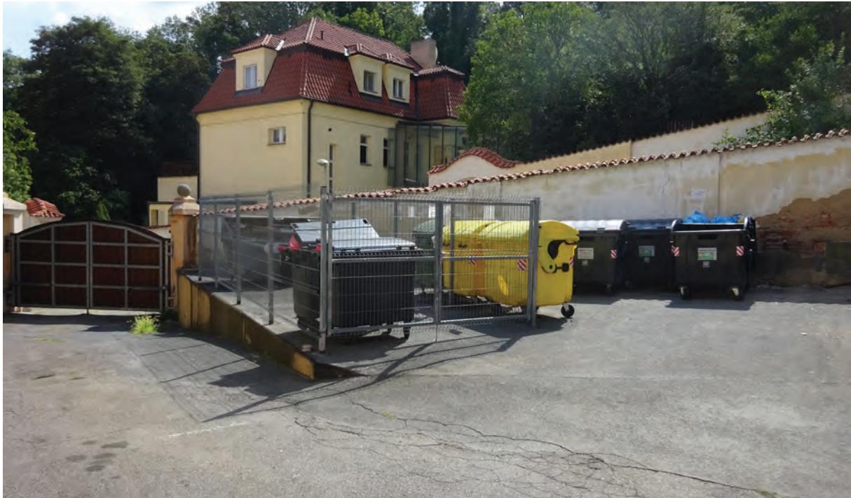
Foto 237: Technischer Bereich, Müllplatz
