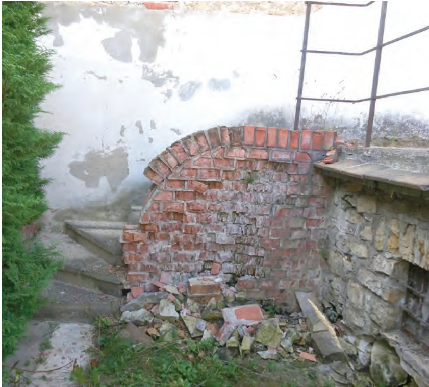
Foto 183: Haus Nazareth, Sockelbereich der ursprünglichen Hausnr. 339/III
