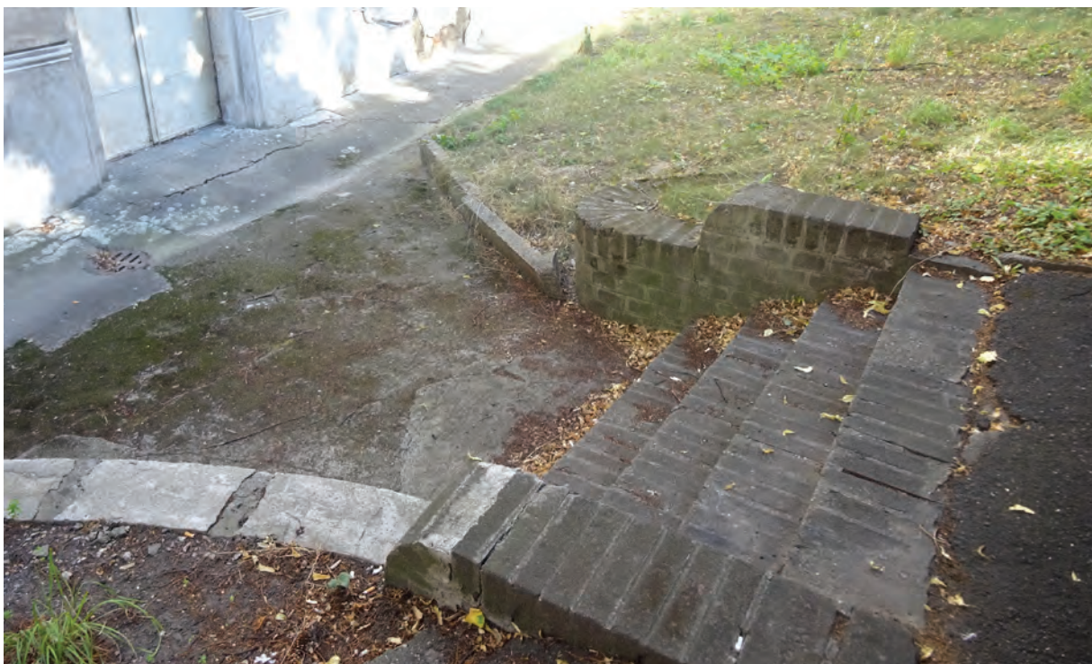
Foto 092: Krankenhaushof, Weg mit Stützmauer, Ziegelstufe (südliche Treppe)
