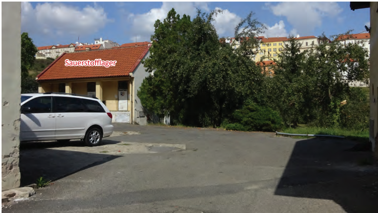
Foto 245: Technischer Bereich, Blick in den hinteren Hof zum St. Josefgarten
