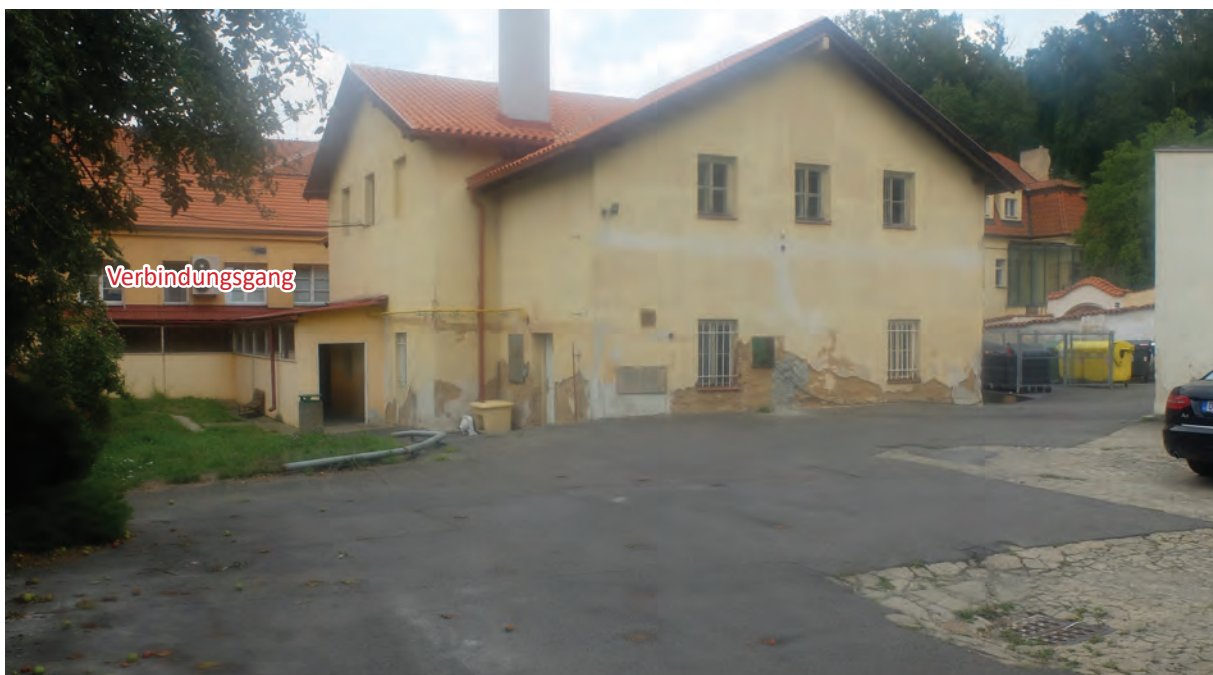
Foto 246: Technischer Bereich, Blick über Hoffläche
