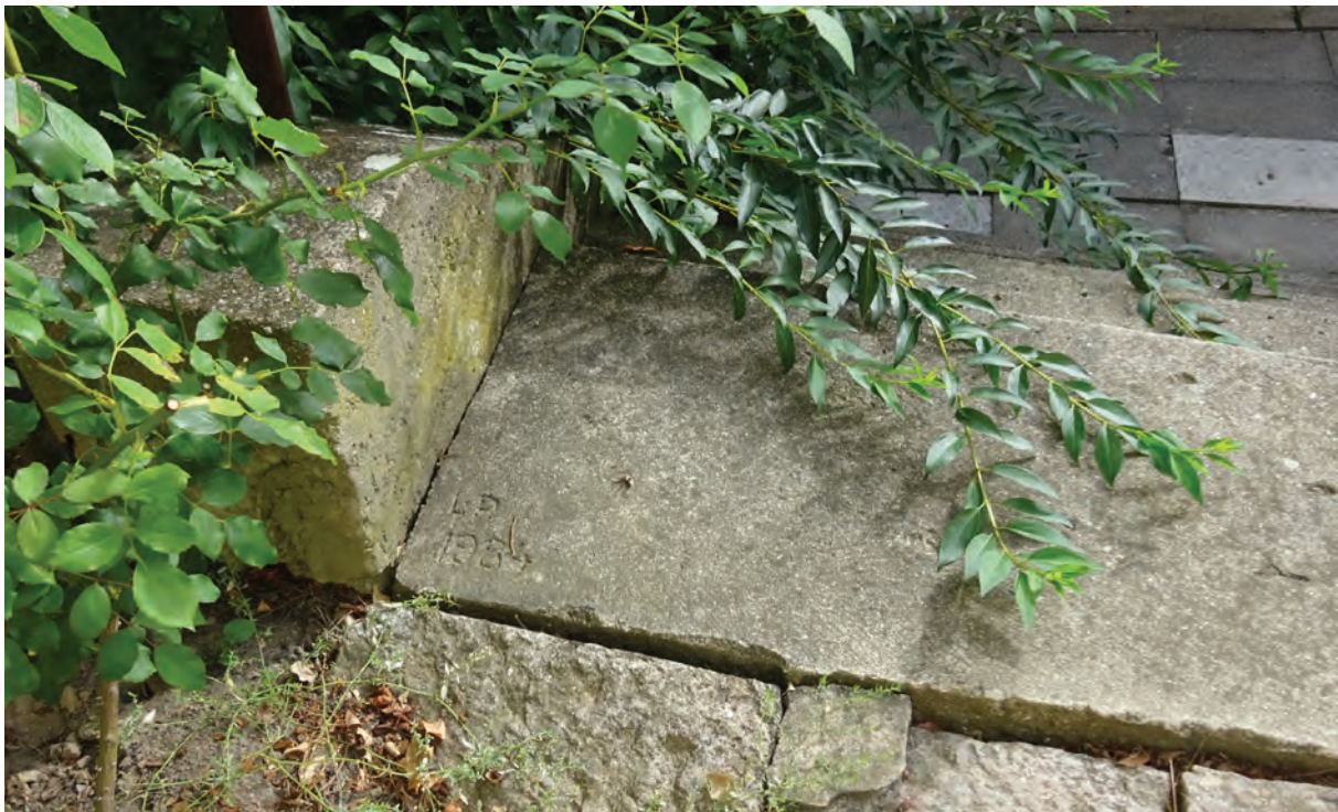
Foto 175: Haus Nazareth, Treppenanlage östlich des Gebäudes
