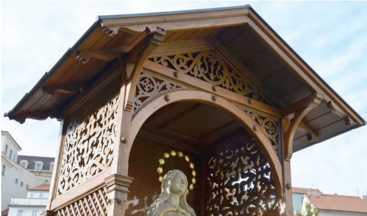
Foto 081: Krankenhausthof, Marienstatue, hölzerne Überdachung
