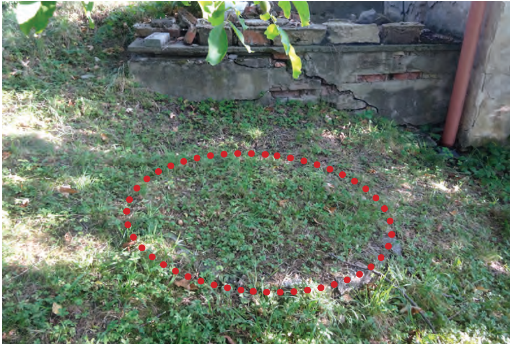
Foto 227: Haus Nazareth, oberste Terrasse, Steinrondell
