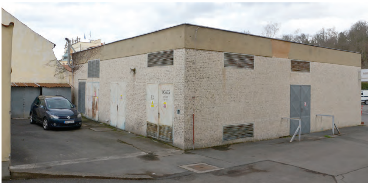
Foto 038: Zugangsbereich mit Parkplatz, Nebengebäude mit Garagen und Trafostation, Ansicht von Nord-Westen
