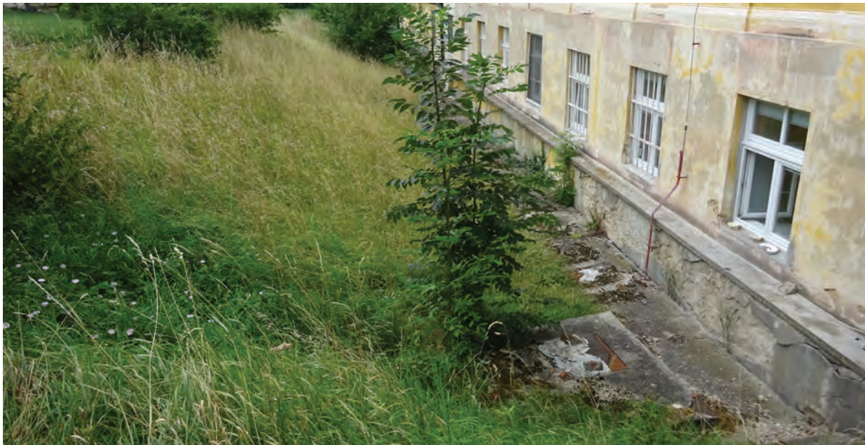
Foto 102: St. Josefsgarten, Böschungsbereich zum tiefer liegendem Krankenhausflügel „St. Antonius“
