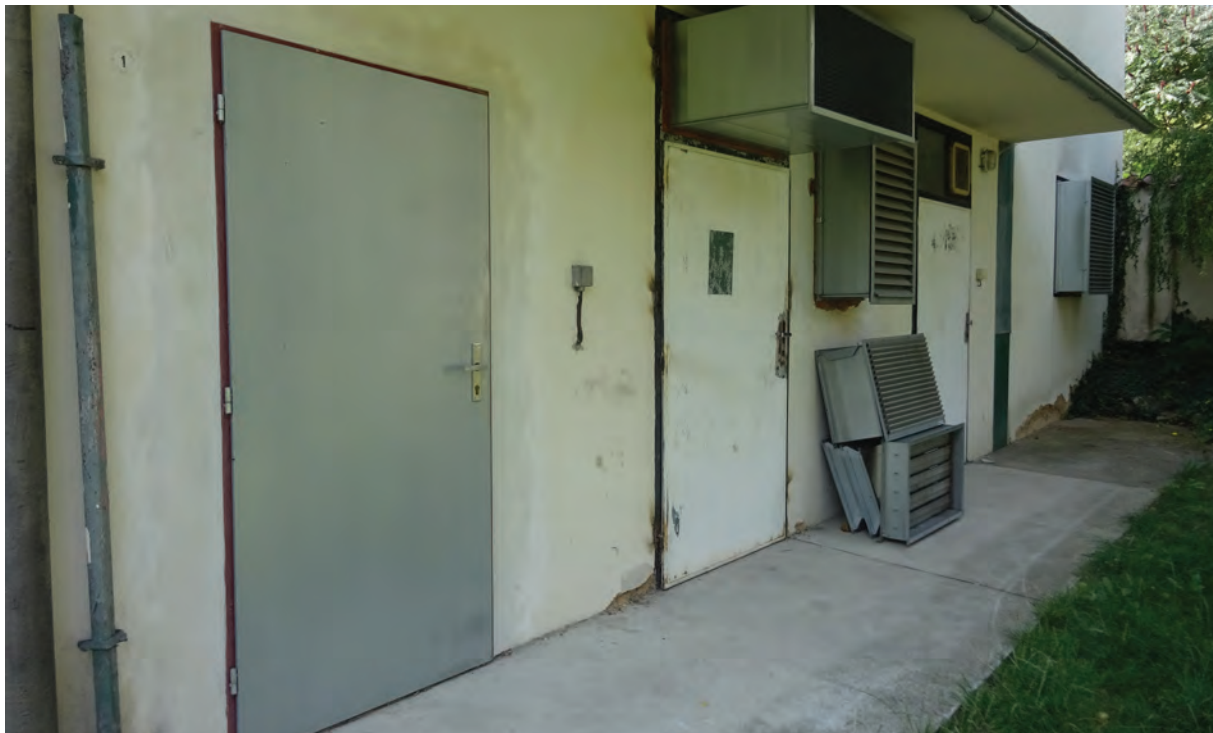
Foto 107: St. Josefsgarten, Gebäude mit Gasflaschenlager (Sauerstoff), Gartenseite
