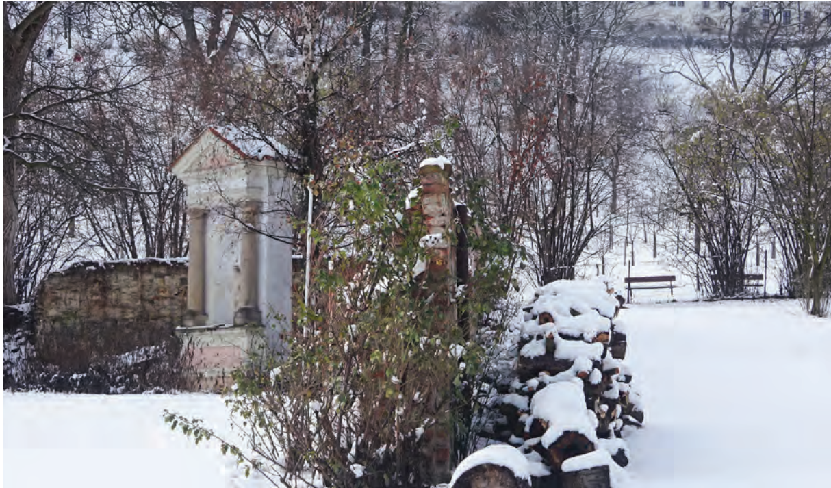
Foto 137: St. Michaelsgarten, historische Einfriedungsmauer
