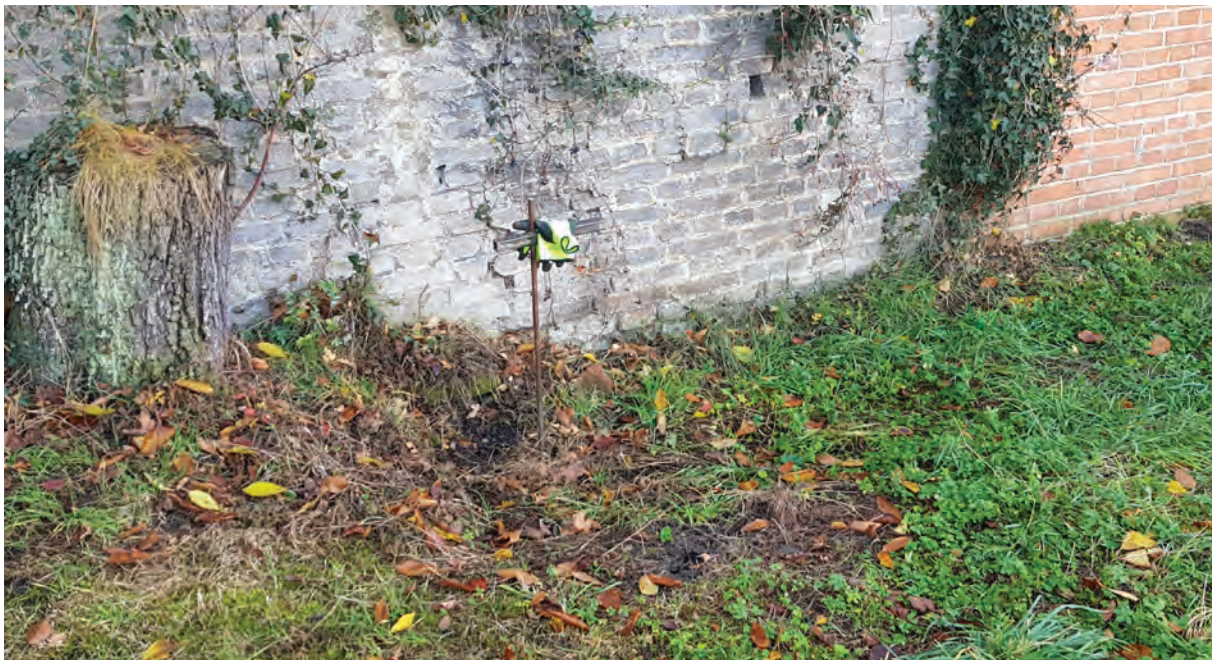
Foto 196: Haus Nazareth, untere Terrassenmauer, verschütteter Wasserbehälter (O3)
