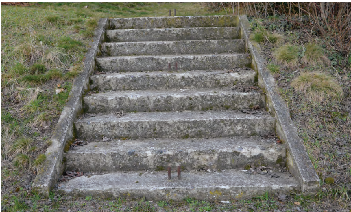
Foto 053: St. Karolusgarten, zentrale Treppenanlage, vierter Treppenabsatz mit neun Stufen
