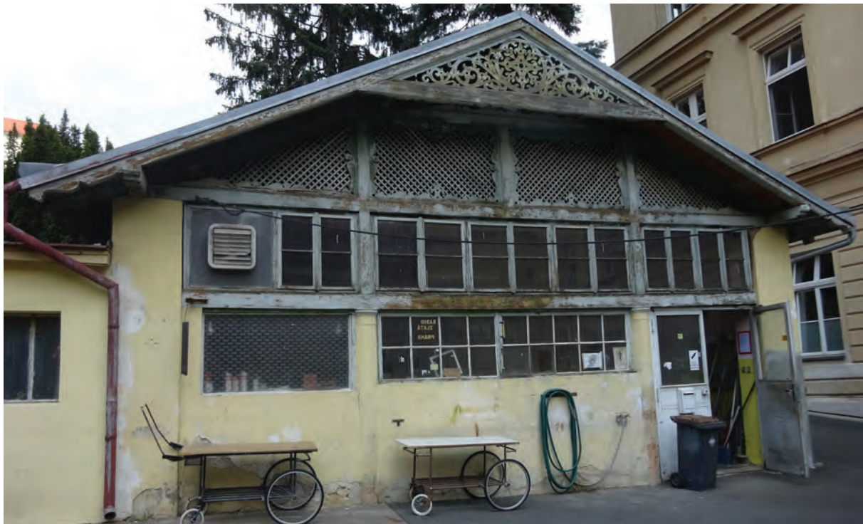
Foto 070: Krankenhausthof, historisches Gartenhaus, Ansicht von Süden
