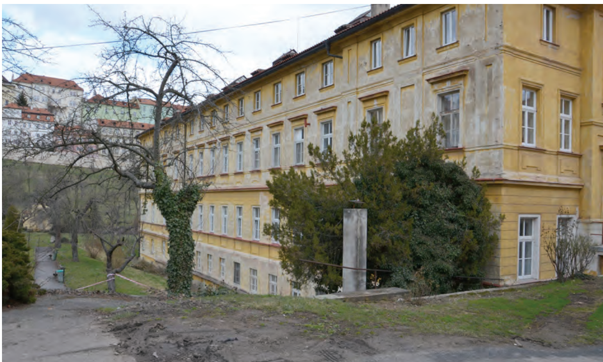
Foto 252: Technischer Bereich, Blick auf den St. Antoniusflügel, Westfassade
