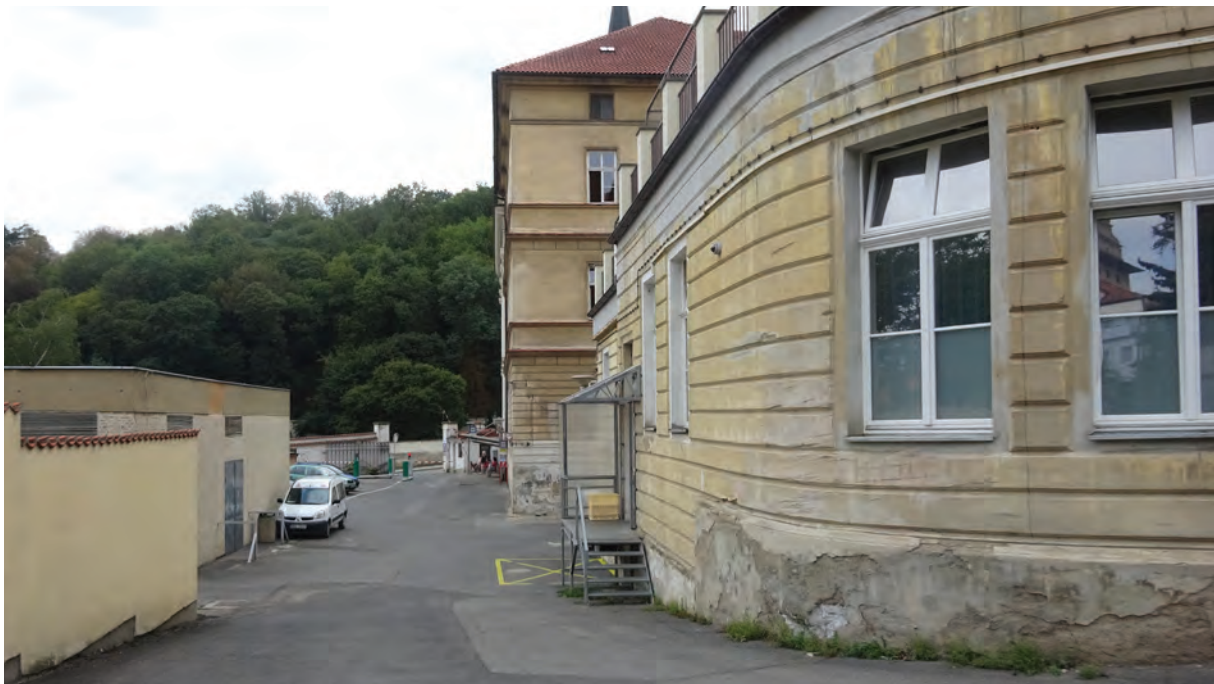
Foto 036: Zugangsbereich mit Parkplatz, Zufahrtsweg zum Parkplatz am St. Karolusgarten (nördlich des Krankenhauses)
