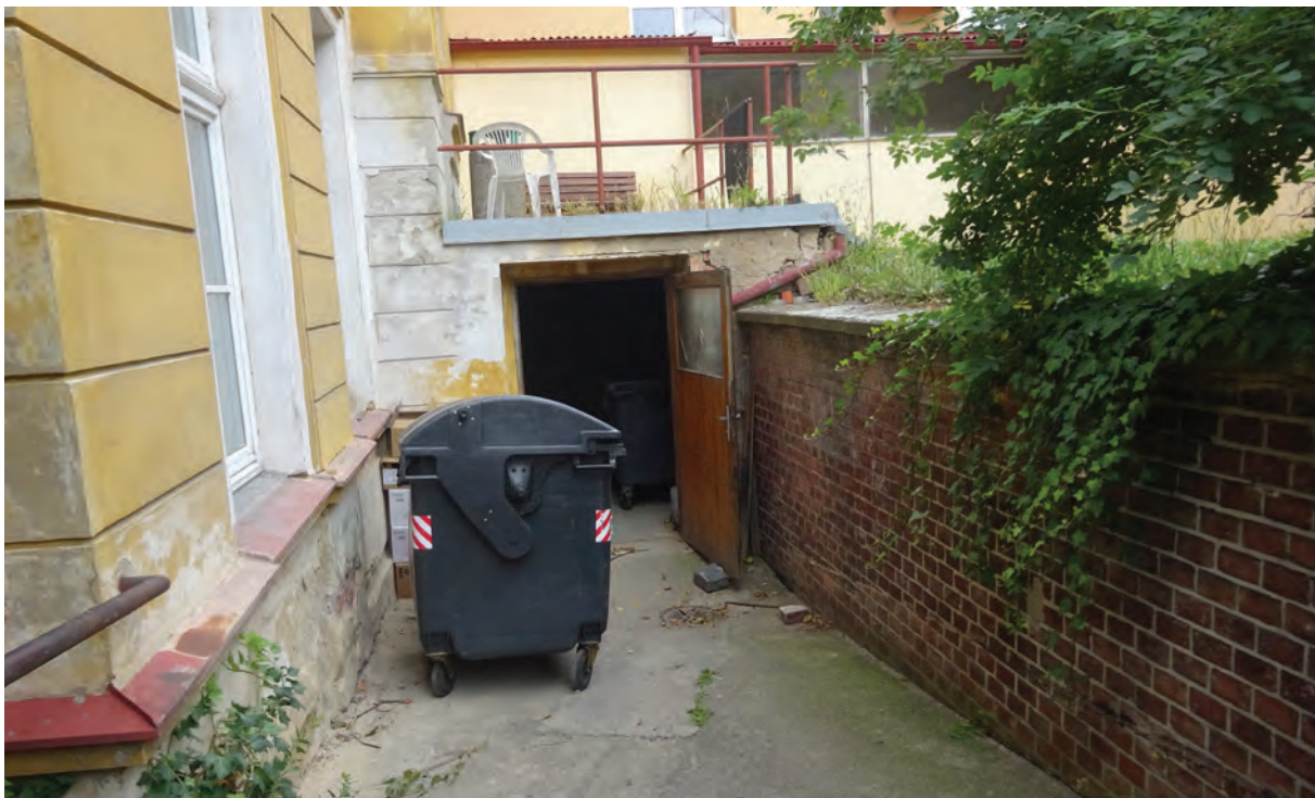
Foto 250: Technischer Bereich, Rampe vom Untergeschoss des St. Antonius-Flügels
