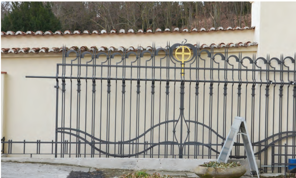
Foto 028: Zugangsbereich mit Parkplatz, Schiebetor
