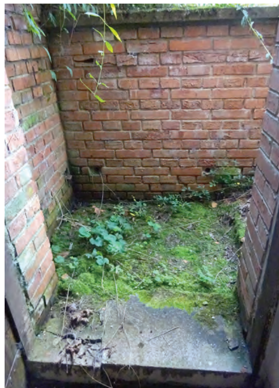
Foto 203: Haus Nazareth, Keller, Zugang
