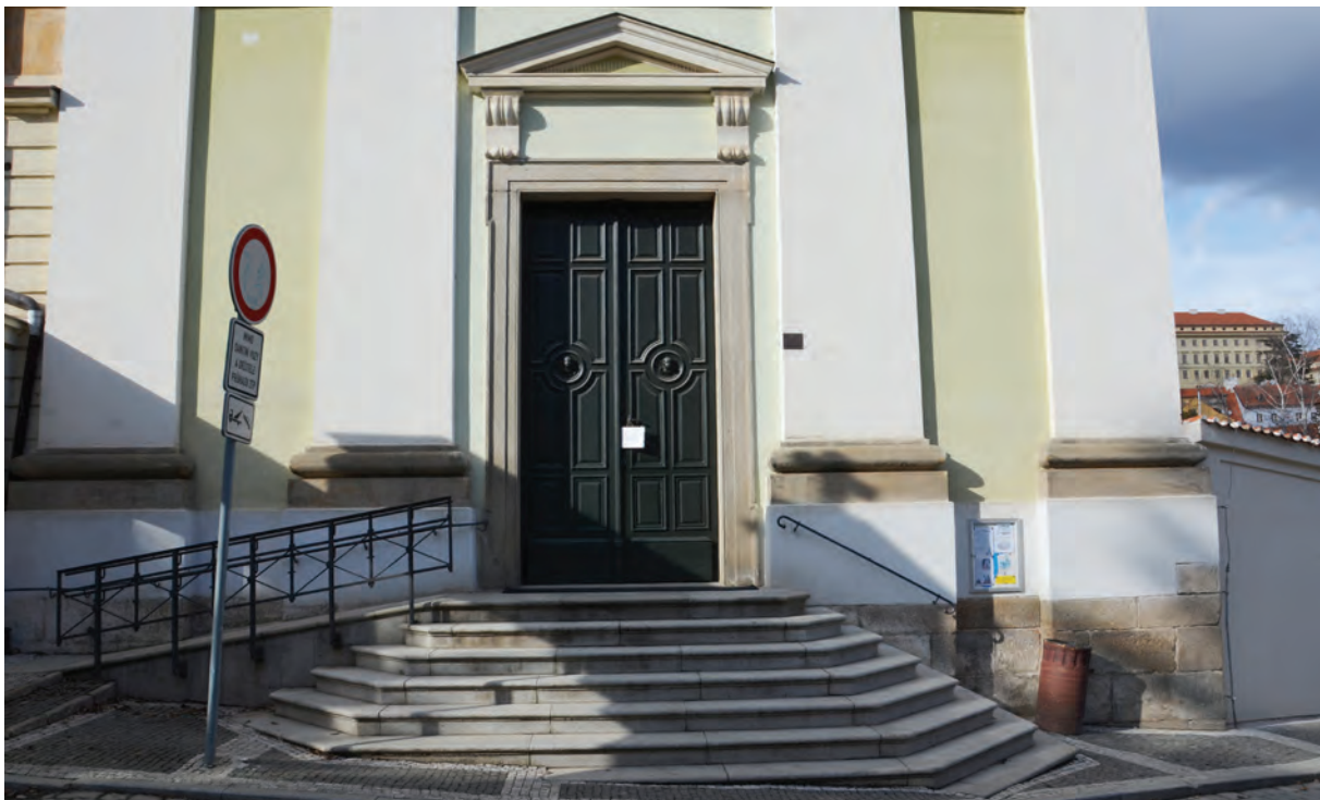
Foto 007: Portal der Kirche vom Hl. Karl Borromäus, östlich des Eingangshofes
