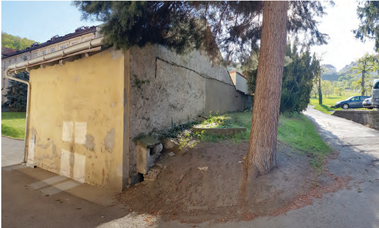
Foto 072: Krankenhaushof, historisches Gartenhaus, Nordseite, Lüftungsschacht (O10)
