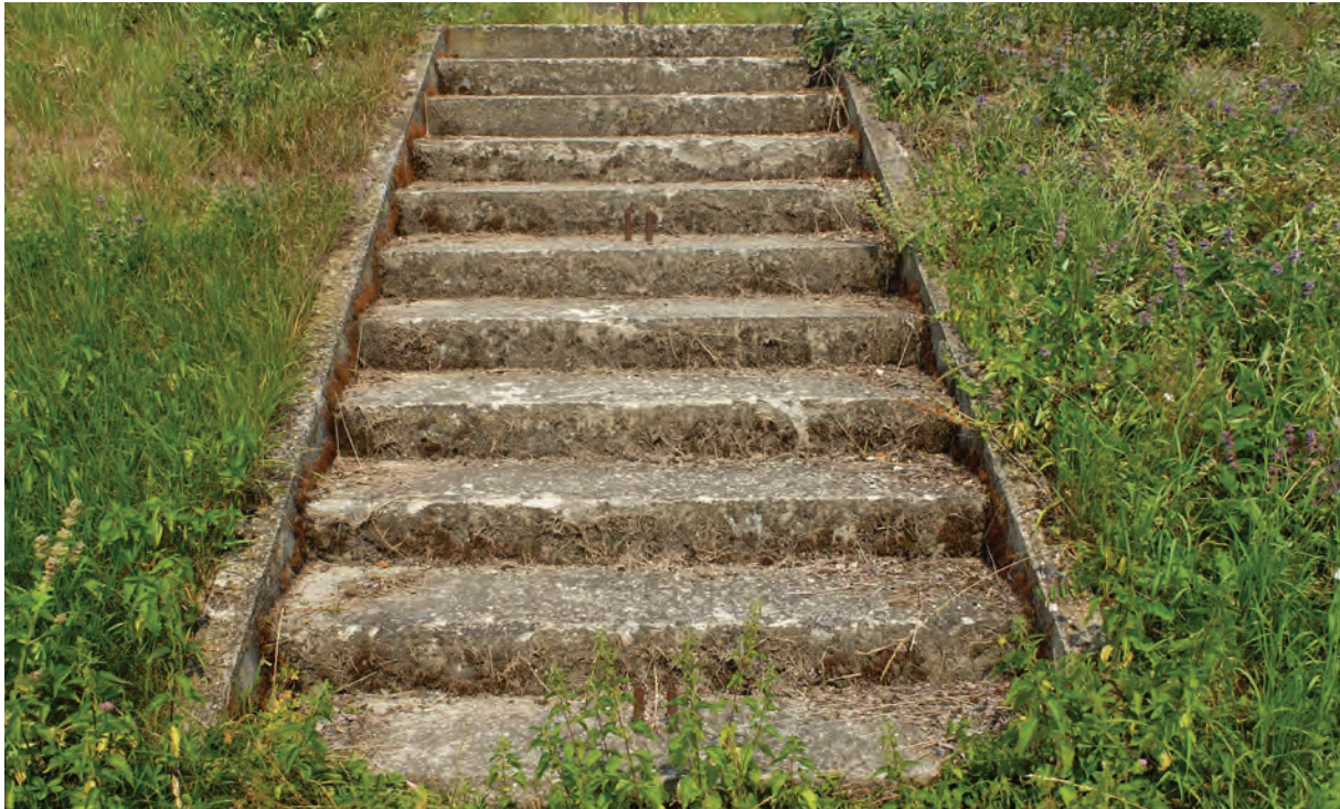
Foto 052: St. Karolusgarten, zentrale Treppenanlage, mittlerer Treppenabsatz mit elf Stufen
