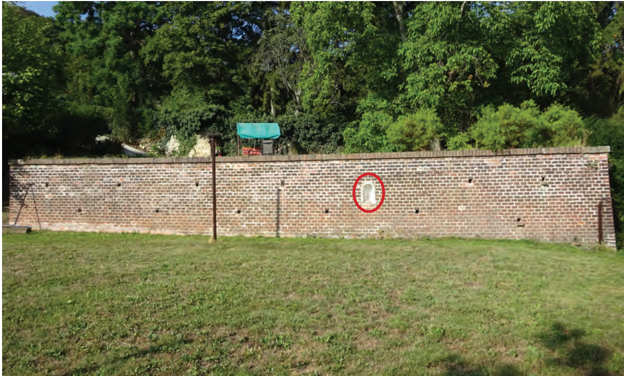
Foto 200: Haus Nazareth, Stützmauer zwischen erster und zweiter Terrasse im nördlichen Bereich
