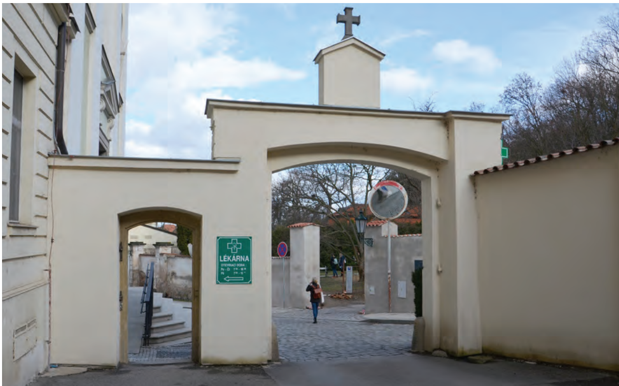
Foto 009: Eingangshof, Toranlage, Hofseite
