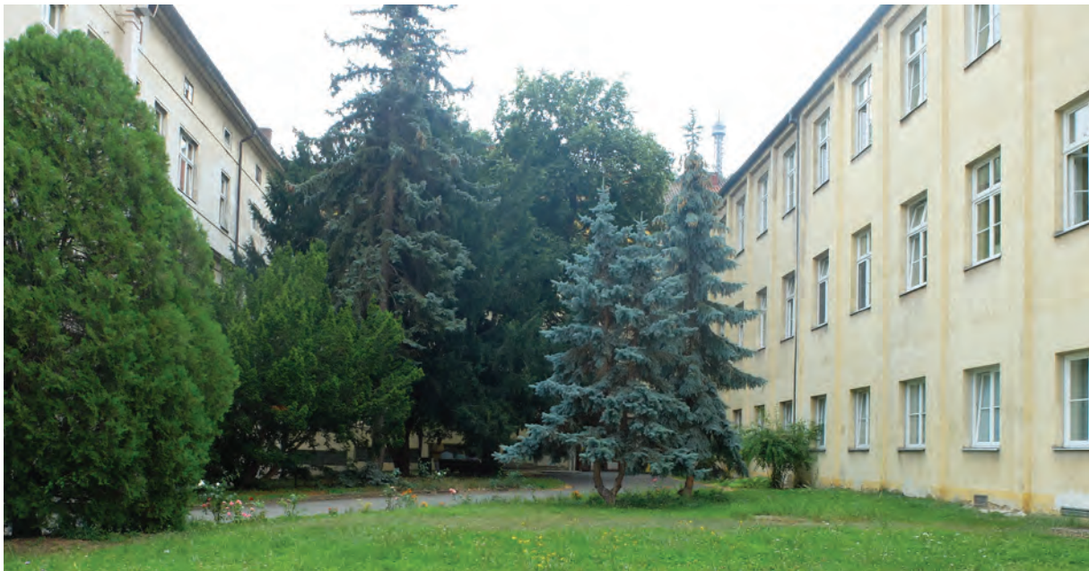
Foto 085: Krankenhaushof, Blick nach Süden
