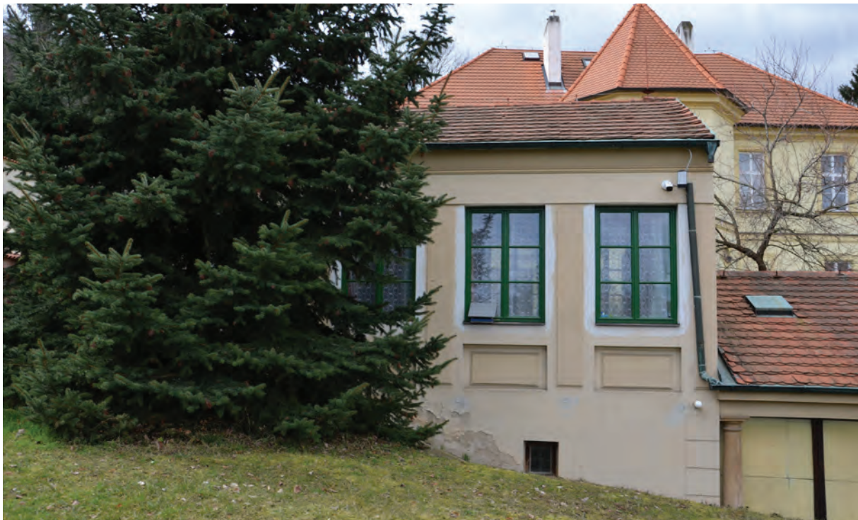
Foto 181: Haus Nazareth, historisches Gartenhaus, Ostseite
