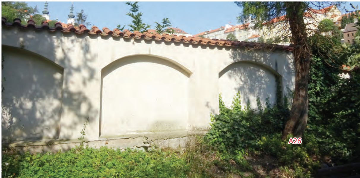
Foto 108: St. Josefsgarten, westliche Einfriedungsmauer
