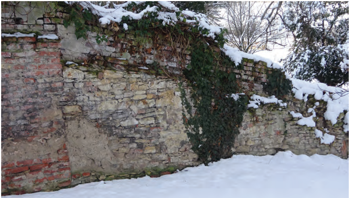
Foto 256: Technischer Bereich, Westseite, historische Mauer
