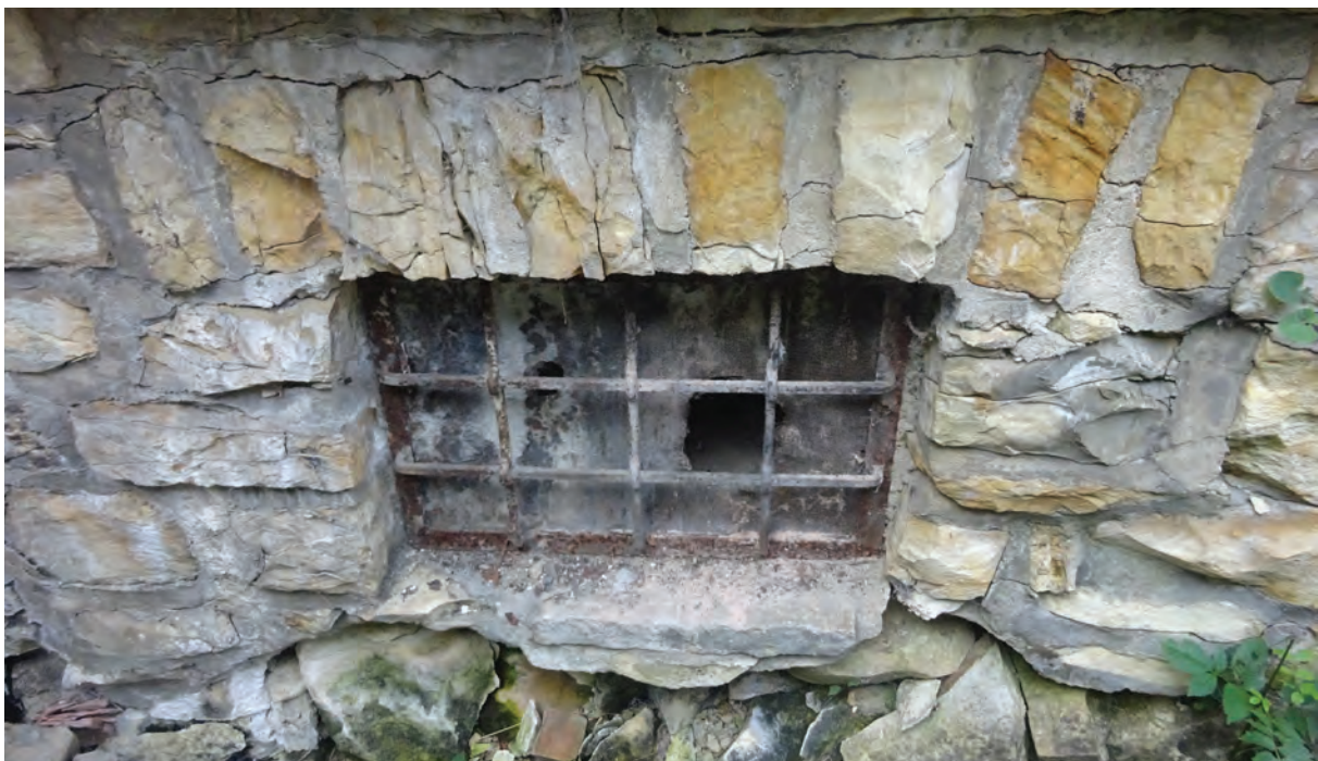
Foto 184: Haus Nazareth, Sockelbereich mit Kellerfenster des ehemaligen Gebäudes Nr. 339/III
