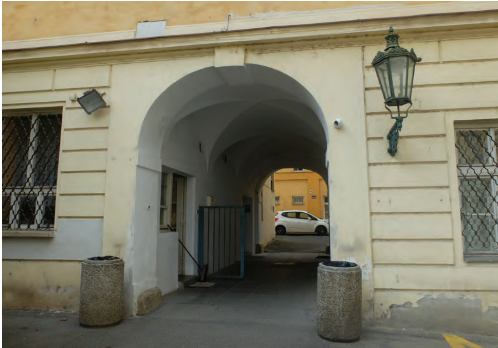
Foto 013: Eingangshof, Durchfahrt des Hauses Nr. 337
